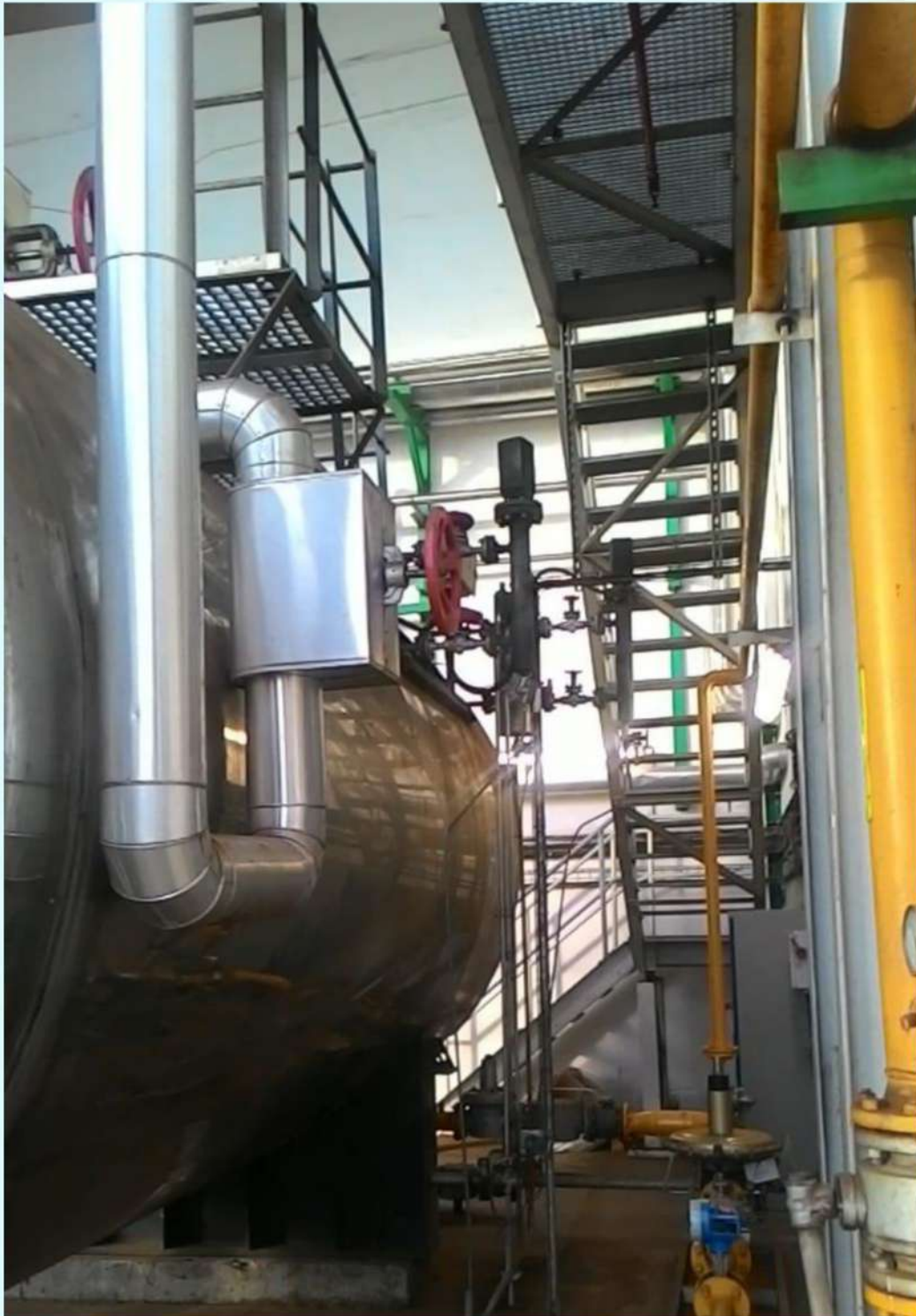
PENGERJAAN PLATFORM BOILER
